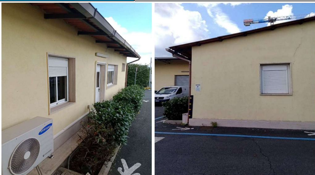
Foto esterno capannone
